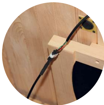
Propojení úzkého kabelu od LED světla pod lavicí
