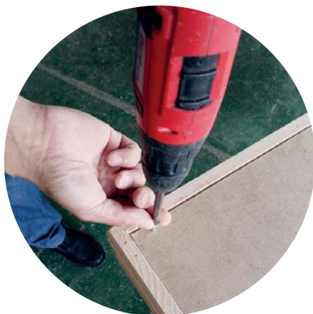
Instalace krytu stropu
