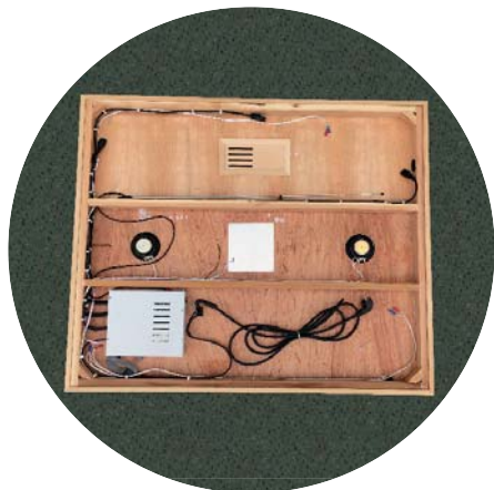
Vrchní část stropu
