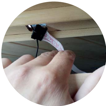
Ukázka protažení kabelů
