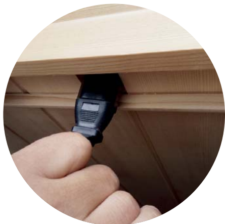
Ukázka protažení kabelů
