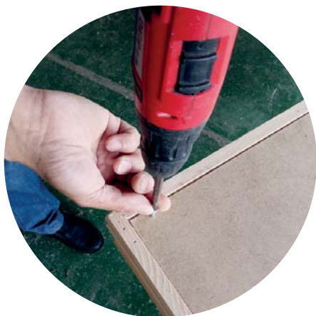
Montáž krytu stropu
