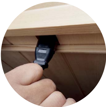
Ukázka protažení kabelů
