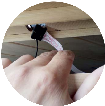
Ukázka protažení kabelů
